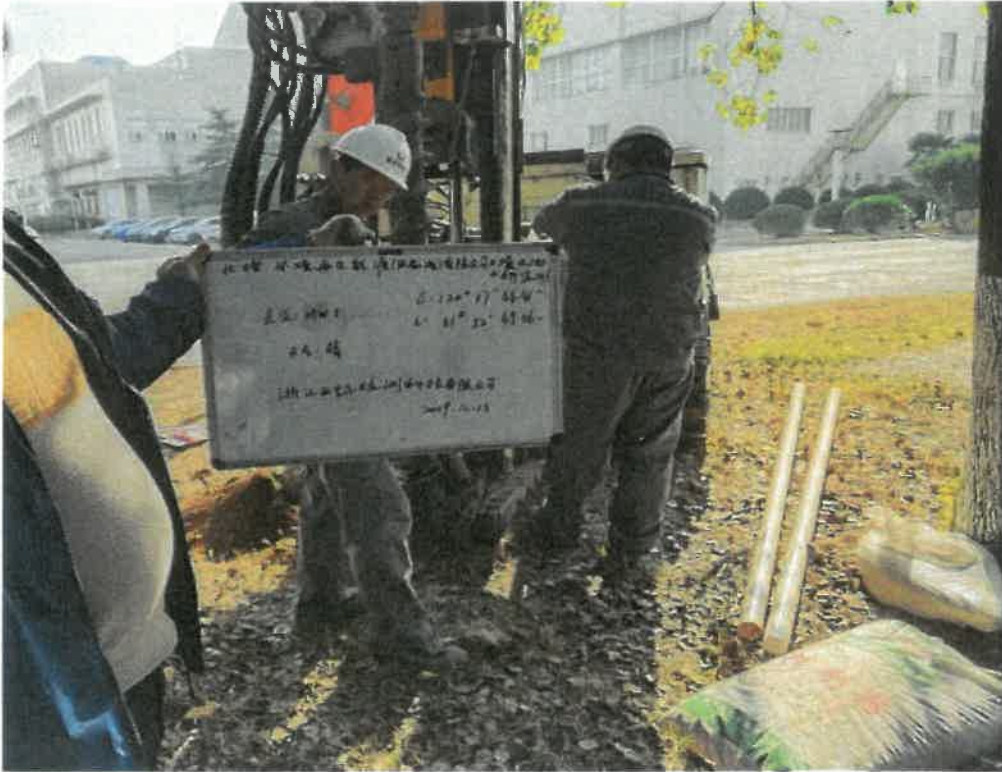
图 5-5 地下水监测井钻孔现场
