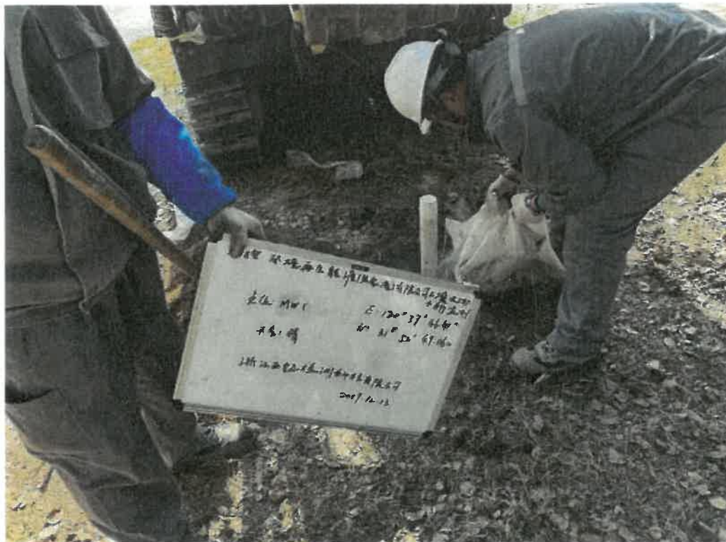
图 5-7 地下水监测井填充滤料与止水材料
