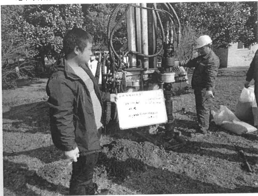
地下水采样—填充滤料和止水材料
