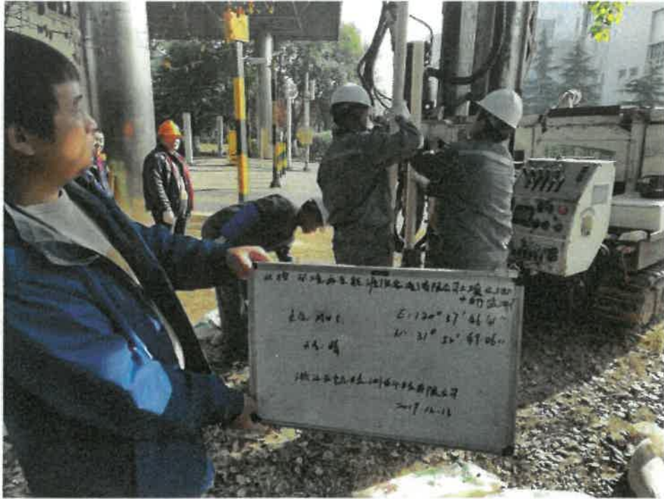
图 5-6 地下水监测井下管（白管）
