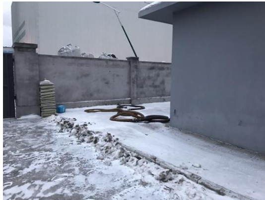
柴油罐区外围墙
