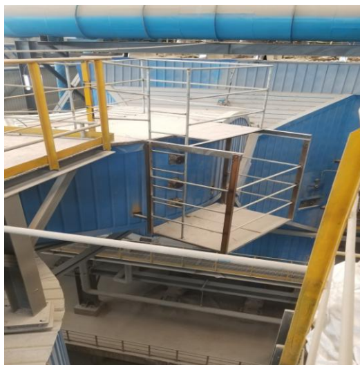
2#600t/d 炉排炉脱硫前采样孔
