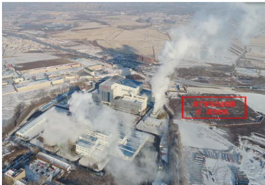
丁家屯现状（已拆除，现为空地）
