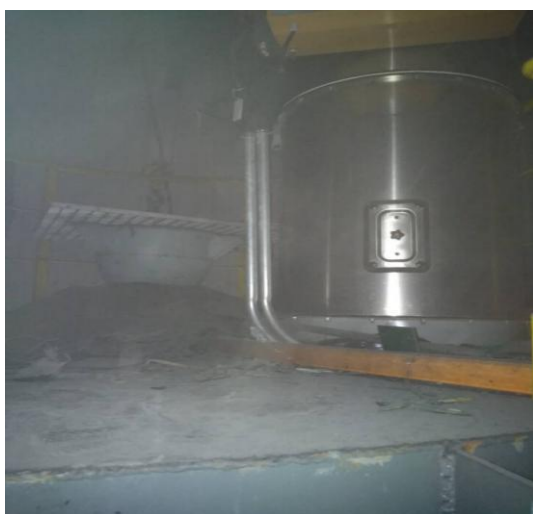
二期活性炭仓顶除尘器
