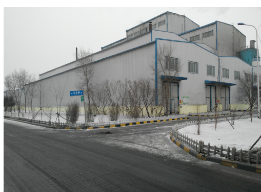
危险废物暂存间（飞灰暂存间）外部
