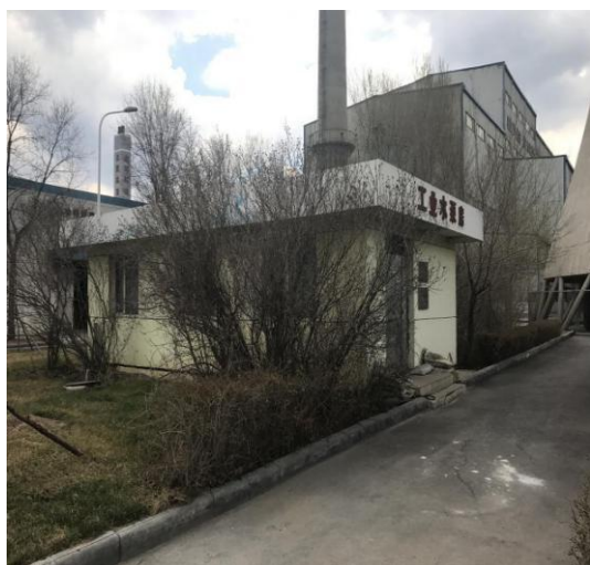
一期工业水泵房
