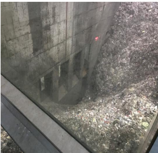
二期垃圾仓外来垃圾卸料口
