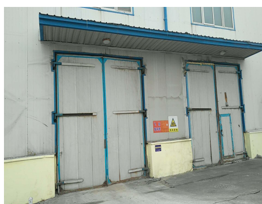
危险废物暂存间（飞灰暂存间）
