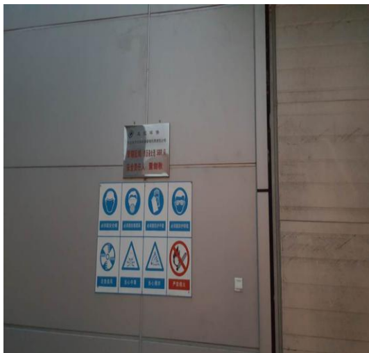
渗滤液处理站
