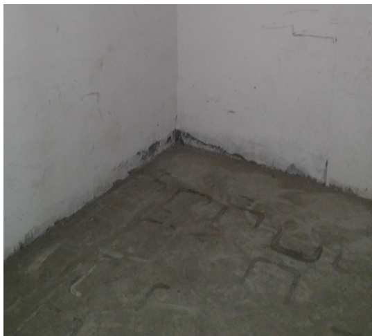
危险废物暂存间内部（废矿物油暂存间）
