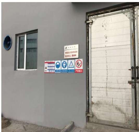
渗滤液预处理间
