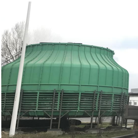
逆流机械通风冷却塔
