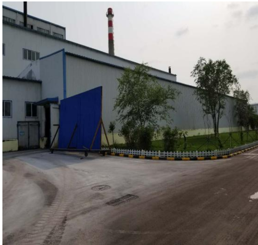
原有危险废物暂存间
