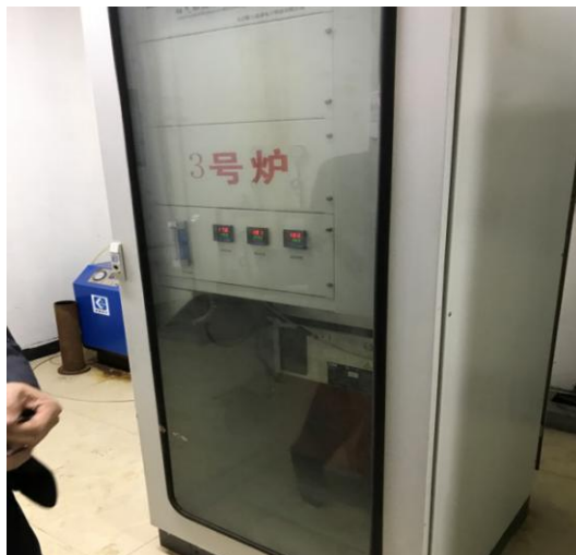
3#600t/d 炉排炉在线设备
