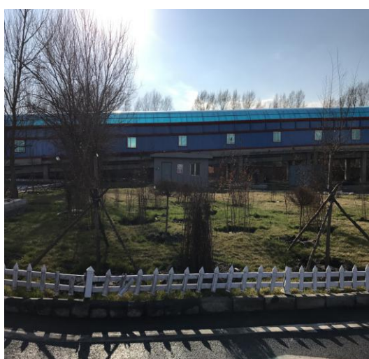
垃圾运输车辆运输廊道
